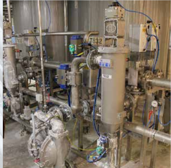
Filtro Auto-line® rotante con motore pneumatico
