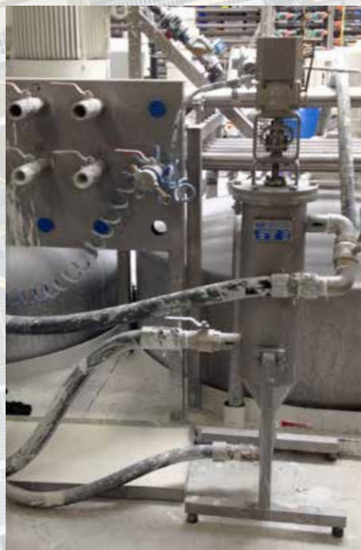
Installazione di filtri per vernici base acqua
