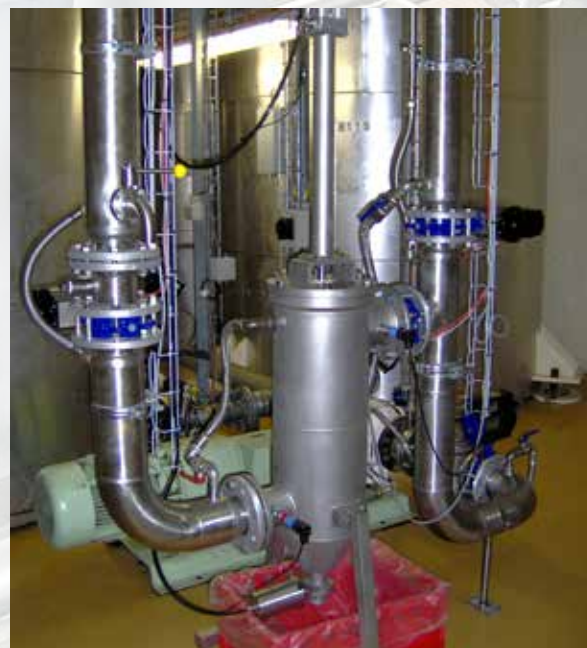
Auto-line® LE per la filtrazione del cioccolato
