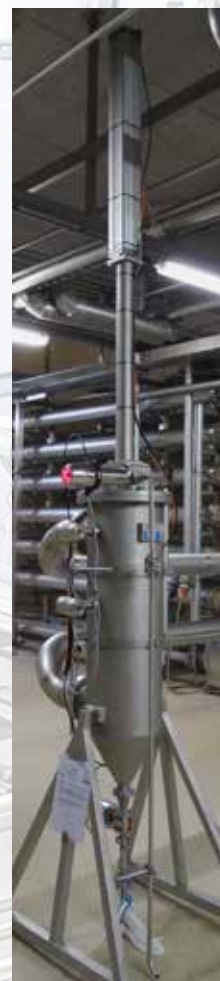
Filtro Auto-line® XXLE police per la filtrazione del condensato prima dell'impianto UF/RO
