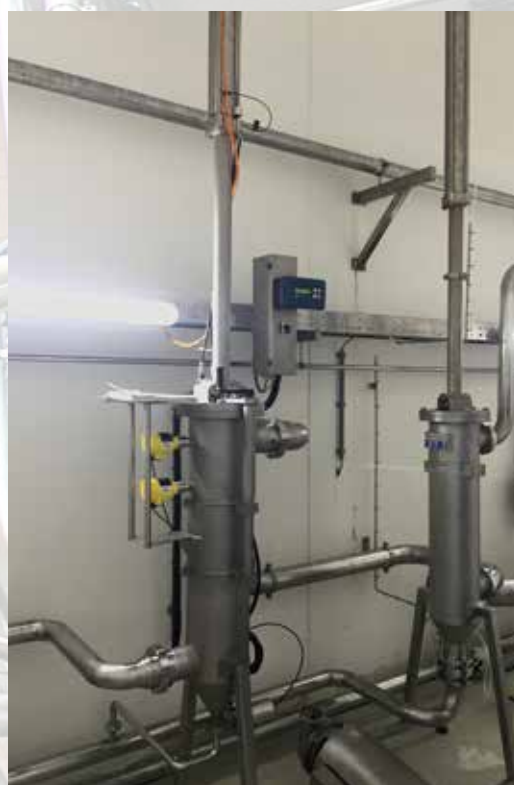
2 pz. di Auto-line® XLE per la filtrazione della salamoia in un impianto di produzione di formaggi a pasta dura
