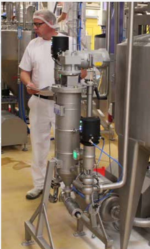
Auto-line® MLR-E per la filtrazione del formaggio fuso
